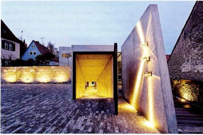
Abb. 8: Ungewöhnliche architektonische Lösung mit einem tunnelartigen Gang zum Keller im Weingut Brennleck in Sulzfeld am Main.
